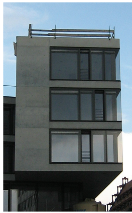
Bild 4.1: Geklebte Ganzglasecken (Münstertor Ulm) Fotos: S. Brendler
