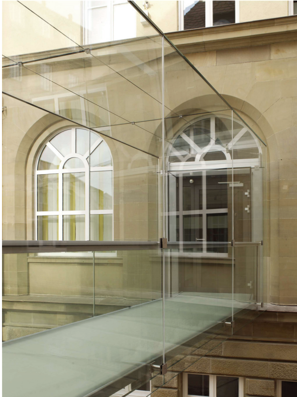
Bild 2.1: Ganzglasbrücke in Schwäbisch-Hall, geklebte Boden- und Deckenplatte
